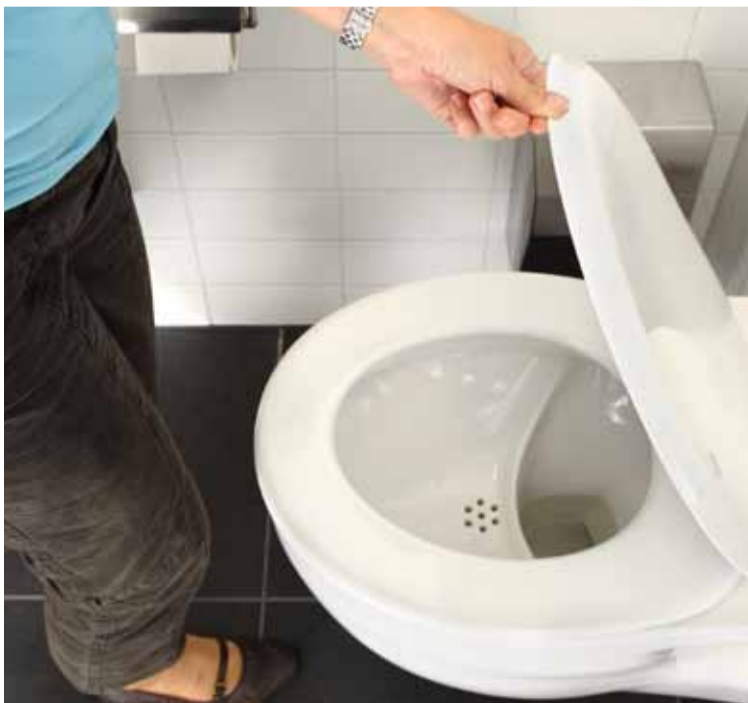
Fig. 3 : Toilettes à séparation et stockage des urines dans le sous-sol du Forum Chriesbach.
