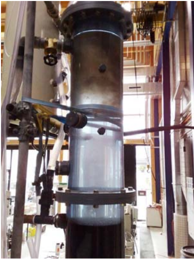
Abbildung 3 Filterüberstau während der 3. Phase des Spülvorgangs (Klarwasser verdrängt mit PAK verschmutztes Spülwasser)
