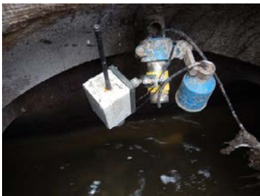
Pegelsensor im Abwasserkanal mit Funkübertragung (Foto: Frank Blumensaat, Eawag)
