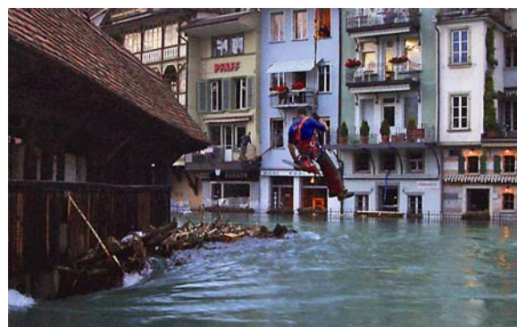
Abb. 5.13 > Räumung der Mühleschleuse in Thun, Kt. BE.
