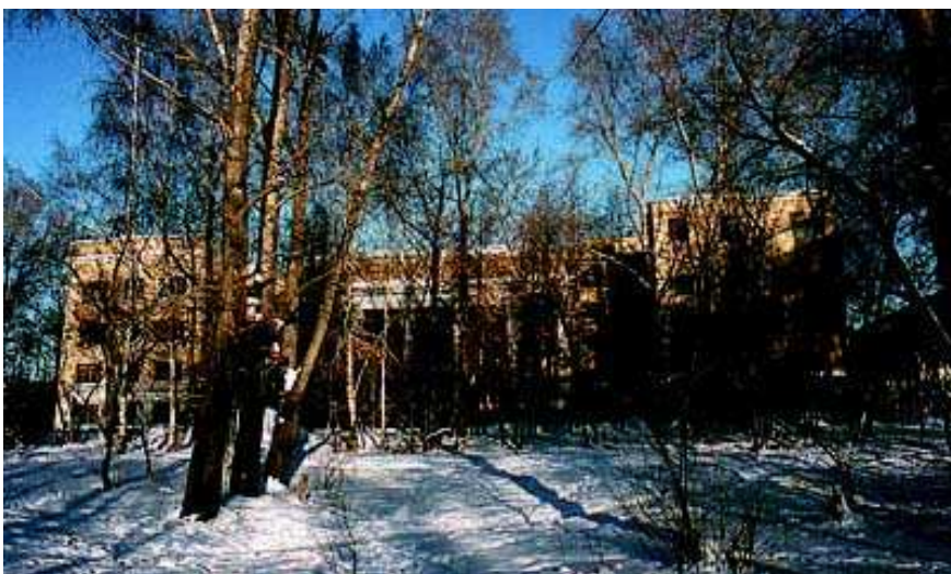
Abb. 1. Das Rektoratsgebäude der Uralischen Forsttechnischen Akademie (UFA) in Jekaterinburg.
