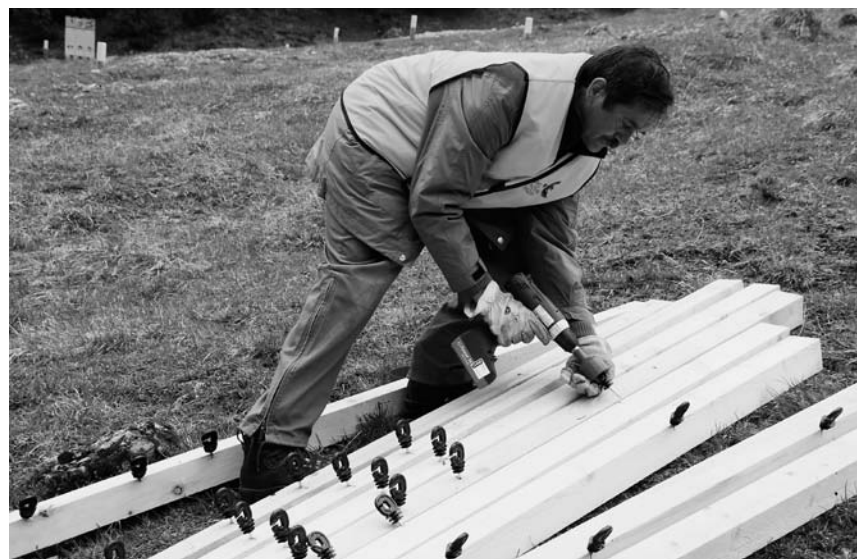
Abb. 7. Vorbereitung der Hauptpfosten zur äusseren Umzäunung. (Foto: Otto Wildi)
