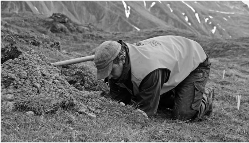
Abb. 3. Grabarbeiten für das Einsetzen der Hauptpfosten. Die dabei geöffneten Bodenprofile wurden zur Probenahme und späteren Bodenanalyse benutzt. (Foto: Otto Wildi) Fig. 3. Digging to plant the main posts. The resulting profiles were used as samples to analyze the soil later on. (Photo: Otto Wildi)
