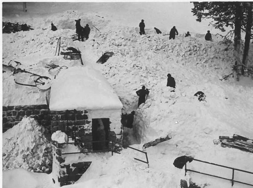
Der südliche Teil des Ablagerungskegels. Aufgenommen am Tage nach dem Unglück. Freilegungsarbeiten an der Strassenschütze und Öffnung des verschütteten Strassen- teils (Foto Lucek XXII/20)
