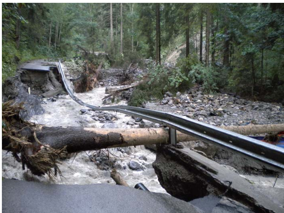
Bild 5. In Saanen BE wurde am 10. Juli ein Strassenabschnitt durch den Chalberhönibach von den Wassermassen zerstört (Luzia Kunz, Thuner Tagblatt).
