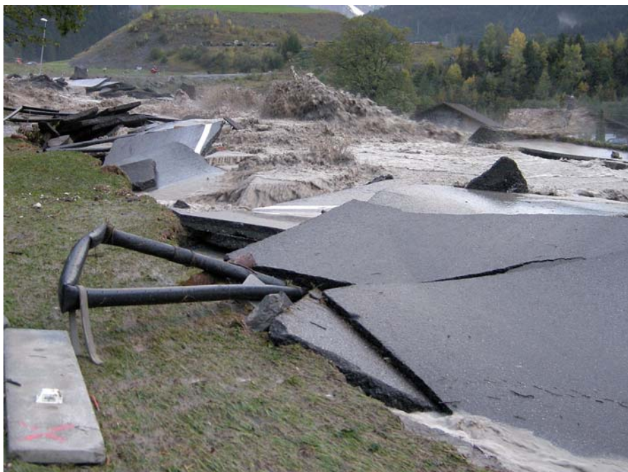
Bild 7. Die Wassermassen rissen in Kandergrund BE am 10. Oktober den gesamten Belag der Kantonsstrasse mit (Philippe Gyarmati).
