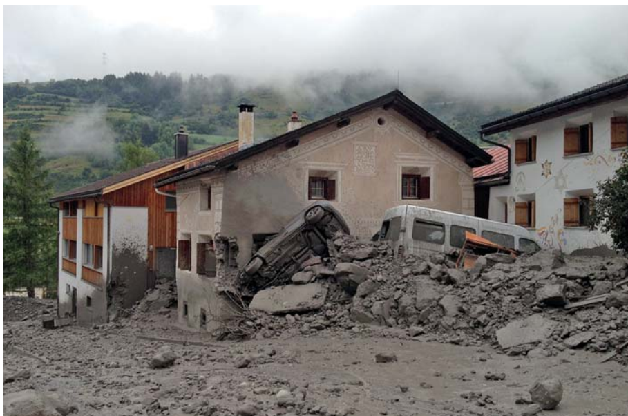
Bild 8. Ein Murgang aus dem Val Triazza beschädigte am 22. Juli in der Fraktion Pradella der Gemeinde Scuol GR mehrere Gebäude (Foto: Amt für Wald und Naturgefahren Graubünden).
