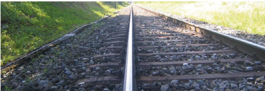
Abbildung 14 Vegetationsfreier Gleisbereich und Übergangszone der intensiven Unterhaltszone. (Quelle: ikko/pixelio.de).
