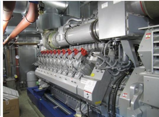
**Abbildung 7** Blockheizkraftwerk zur Verstromung des Biogases. (Quelle: schau.media/pixelio.de)
