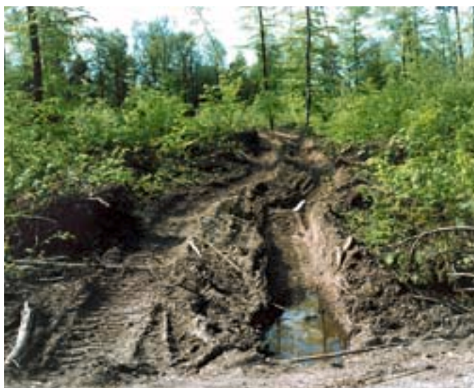
Abb. 2. Schwere Maschinen für die Flächenräumung verdichten den Boden und erschweren die Wassersickerung und Durchlüftung für lange Zeit. Bild W. Schönenberger.
