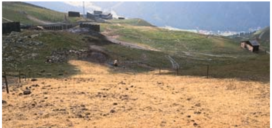
Abb. 2. Hydrosaat: Aufspritzen eines Samengemisches kombiniert mit flüssigem Dünger und Klebstoff in schwer zugänglichem Gelände und mit einer Strohecke kombinierte Hydrosaat kurz nach der Fertigstellung auf einer Skipiste in der alpinen Zone.
