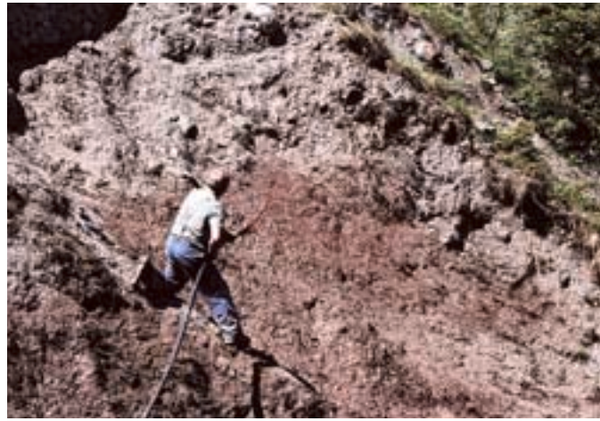
Fig. 2. Ensemencement hydraulique: Un mélange de semences additionné de fertilisants liquides et de liants vient d'être répandu sur ce terrain difficilement accessible. La piste de ski, dans la zone alpine, a également été recouverte d'une couche de paille.
