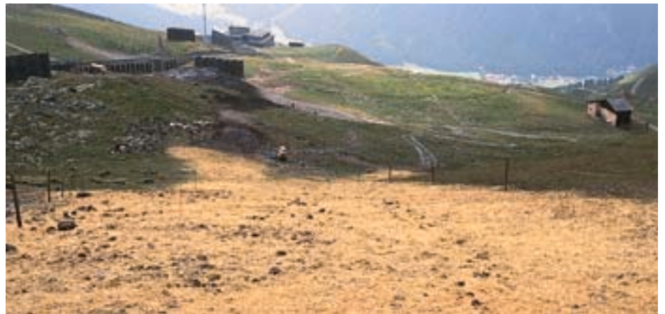
Fig. 2. Ensemencement hydraulique: Un mélange de semences additionné de fertilisants liquides et de liants vient d'être répandu sur ce terrain difficilement accessible. La piste de ski, dans la zone alpine, a également été recouverte d'une couche de paille.
