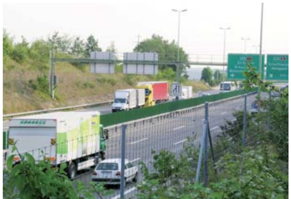
Fig. 4. Autoroute A1 près de Winterthour. Les autoroutes sont autant de barrières pour de nombreuses espèces animales. Clôtures et circulation intense augmentent encore l'effet de séparation des routes.
