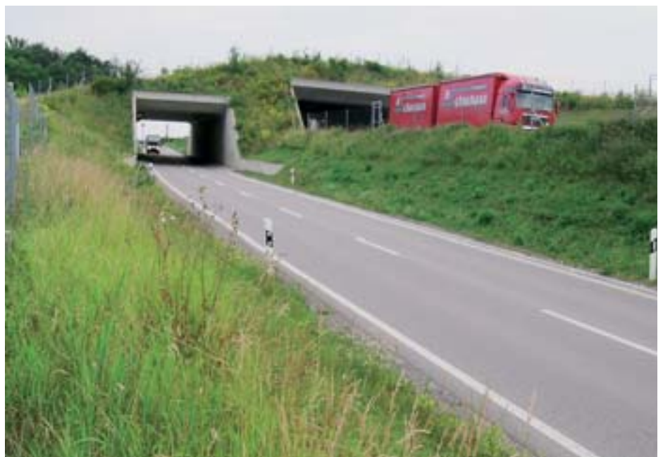
Fig. 9. Passage à faune au-dessus de la N4 près d'Andelfingen, dans le Weinland zurichois. Les passages à faune atténuent l'effet de barrière des routes et réduisent le nombre d'animaux tués.
